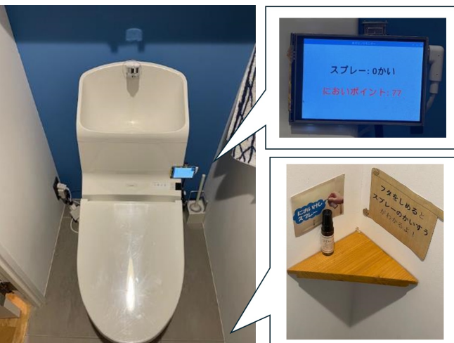
図2 仕掛け設置の様子
